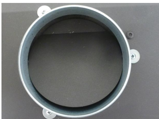
Figura n°8 - Tobera correctamente atornillada en los 3 puntos con sus arandelas
