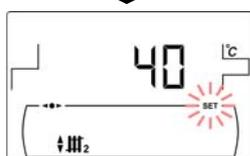
Consigna de temperatura de ida del circuito mezclado nº 2 seleccionada mediante el selector táctil correspondiente **(18)**.
